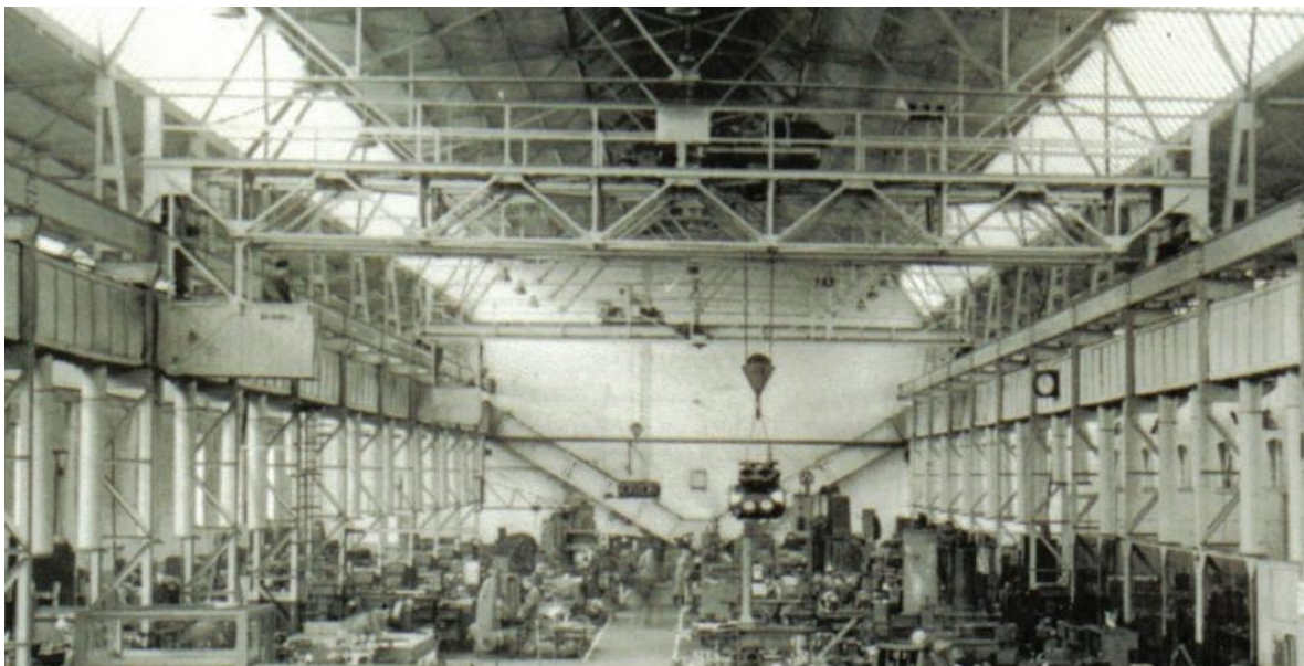
Foto 1, Bovenloopkranen in Hal 1 bij Grasso Den Bosch 1952, Bolzani (D)
