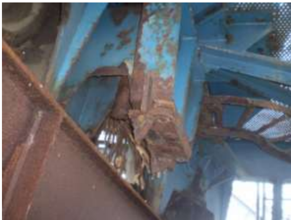
Achterste zwenkrandwielen met de bonkelaarfundatie (foto GJ)
