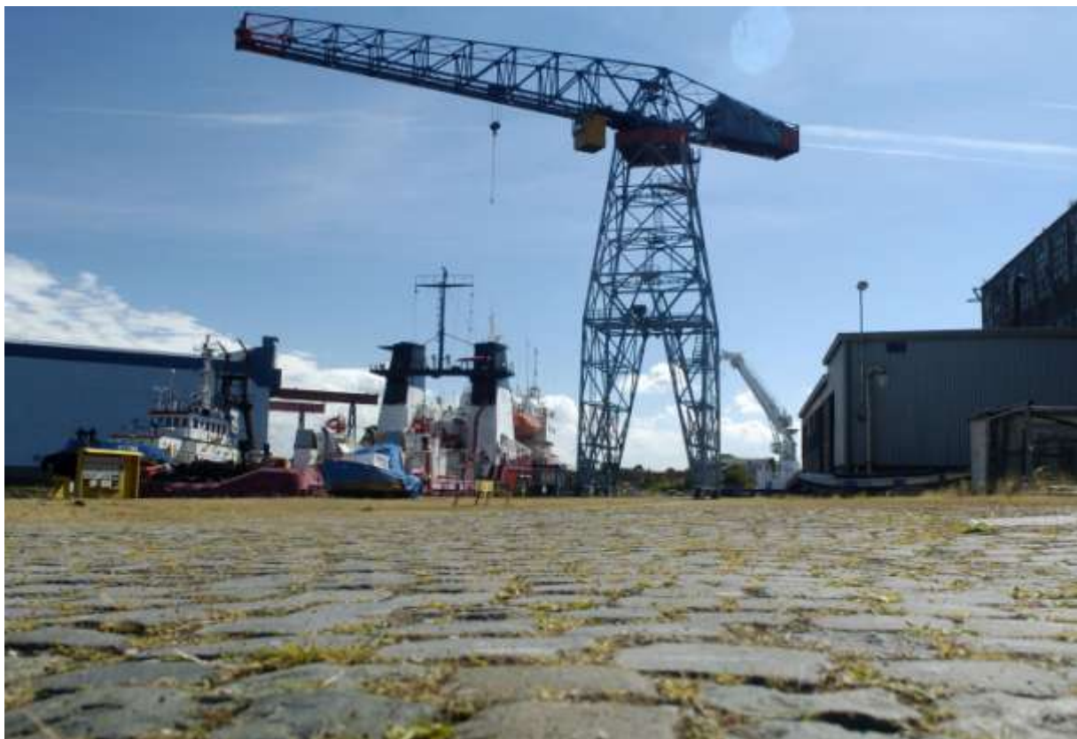
Kraan aan de Timmerfabriekskade
