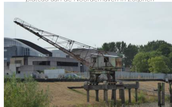
De Rörink & Van den Broek kraan op het betonnen plateau aan de Noorderhaven in Zutphen
