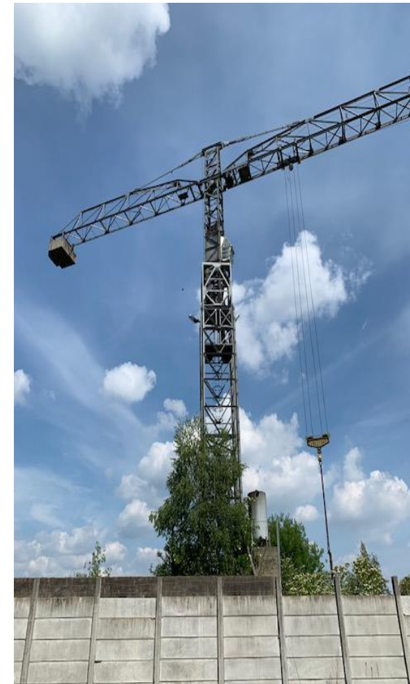
Bouwkraan Richier Weitz (Foto Gerard Hendriks)
