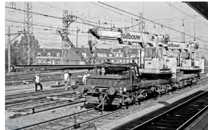
Twee gekoppelde vierassige hydraulische WMG spoorwegkranen van Railbouw aan het werk in Utrecht.
