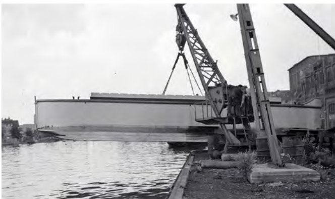
Bij de Zaanlandse scheepsbouw Maatschappij, vestiging Wormer, wordt met behulp van de Derrickkraan één van de vier 'bakjes' voor Suriname te water gelaten.
