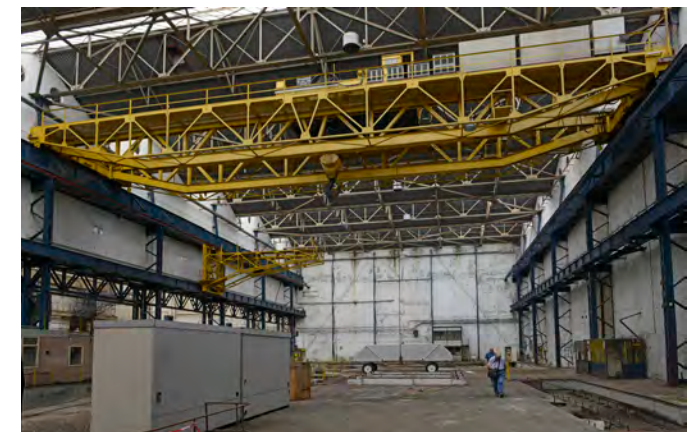
Brugkraan 534-61 (hijsvermogen 20 - 100 ton en verrijdbare wandkraan 524-61 (fabrikaat Thole met 1600 kg hijsvermogen, hal 3.
