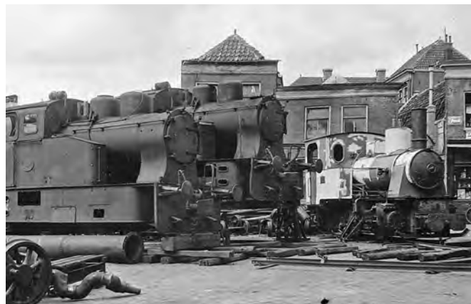
Machinefabriek De Weger werkte ook aan locomotieven. Locomotieven 65 en 57 van de Nederlandsche Tramwegmaatschappij (NTM) staan in 1947* naast een aannemerslocomotief bij de fabriek. Ze krijgen daar een zogenaamde grote herstelling.
