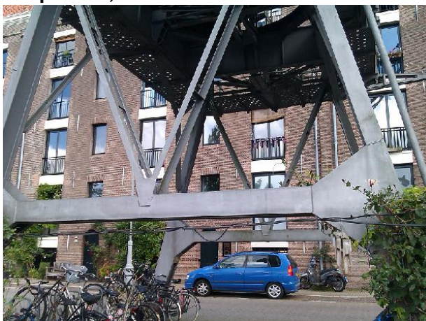
Kraanportaal en onderkant zwenkrand met Koningsspil. (Foto's: GJ)
