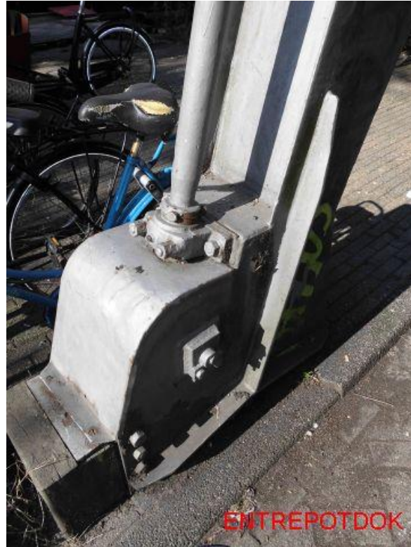
Detail wielaandrijving. (Foto's: Figeo)
