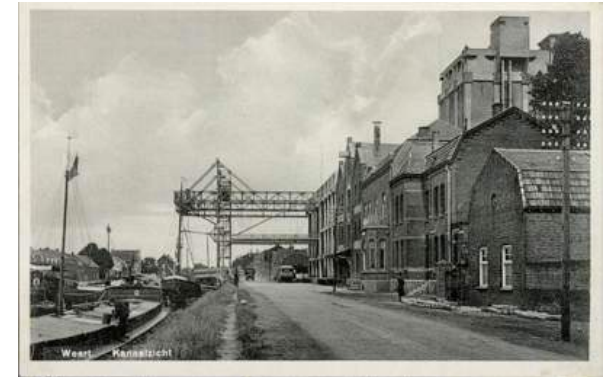
De hijsinstallatie in 1931 (ansichtkaart)
