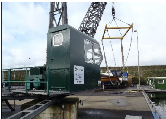
Derrick kraan, cabine en machinehuis
