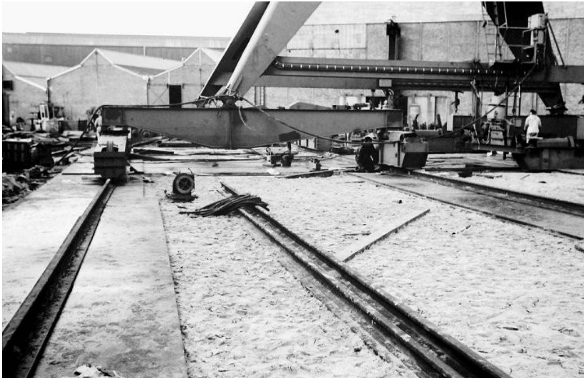
Begin van het verplaatsen van de kraan , links een drie-wielig stel en rechts een twee wielig stel. (Foto: Ruud van der Sluis)
