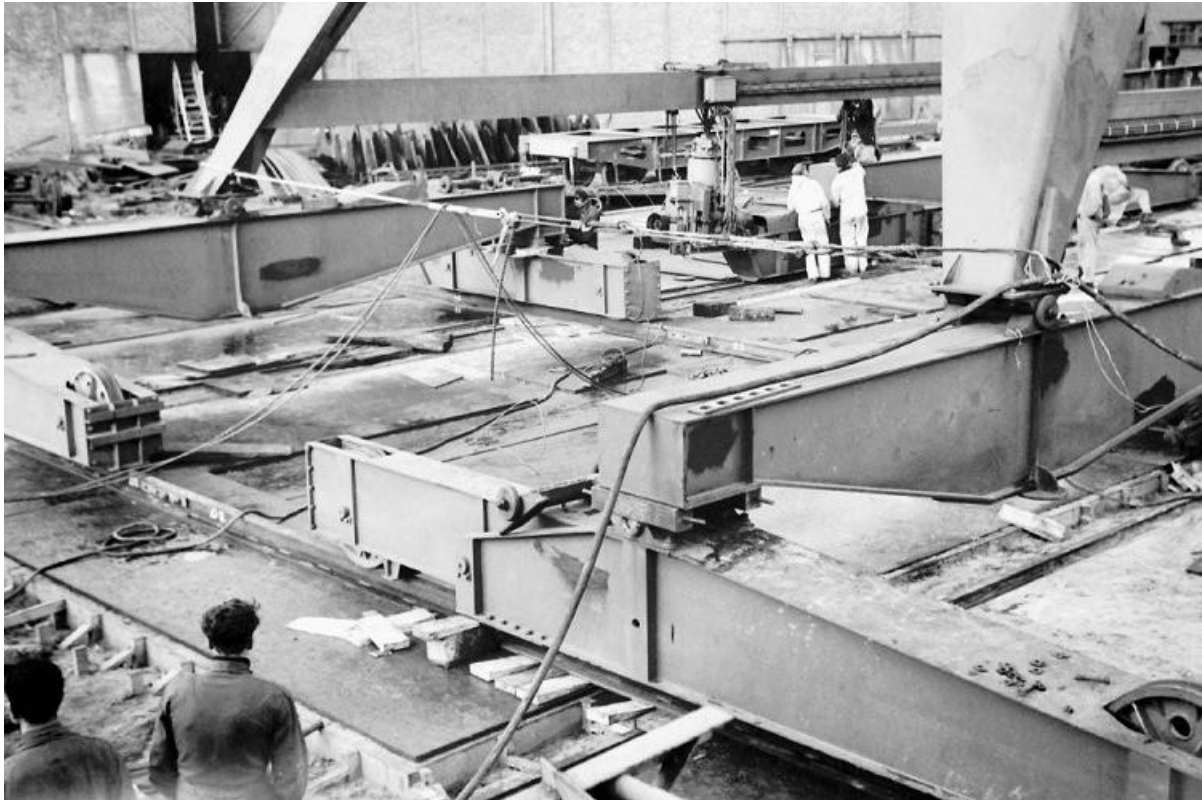
Kraan tijdens het verplaatsen, voor het verband zijn er spankettingen aangebracht. (Foto: Ruud van de Sluis)
